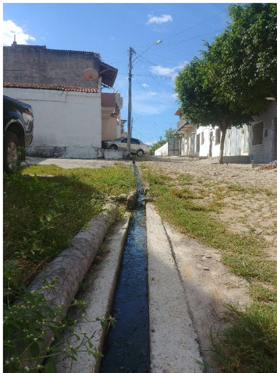
Vista do escoamento de esgoto a céu aberto
