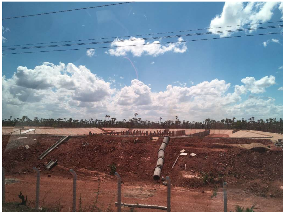
Vista da ETE em execução pela CAGECE (dezembro/2019)
